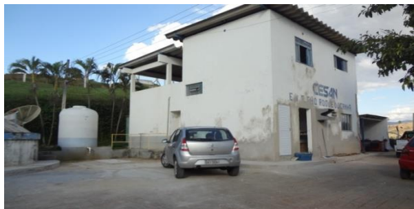
Figura 3-28 - Estação de Tratamento de Água.
