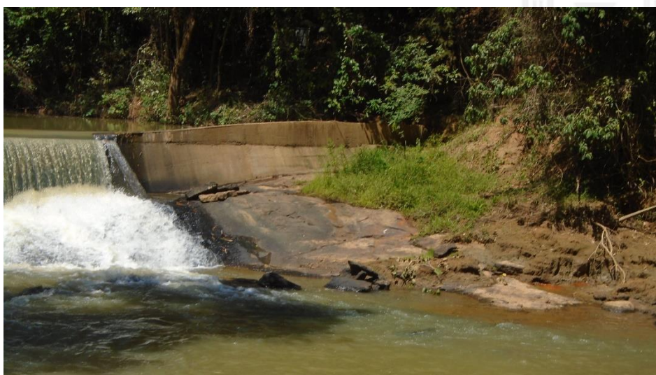
Foto 5: Rocha sã exposta nas laterais do barramento existente.
