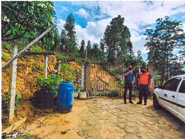
FOTO 09 – Final do pavimento intertravado de concreto, nesta porção do Bairro Nossa Senhora das Graças
